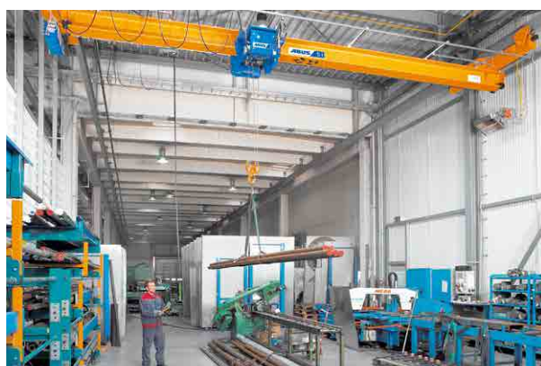
Jednosíková kočka v provedení E na stropním mosto- vém jeřábu EDL
