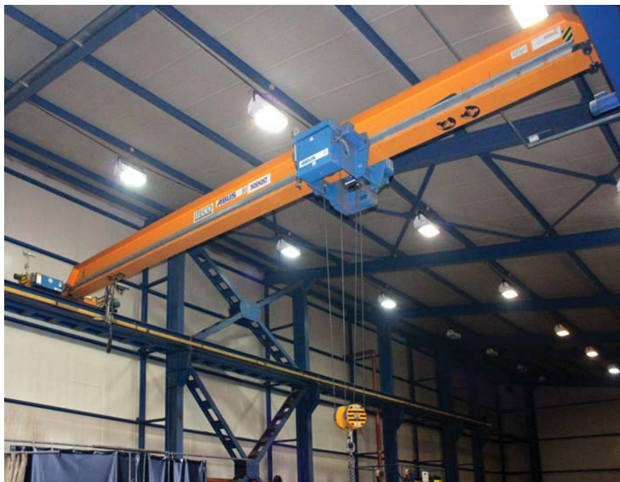
Jednosníkový mostový jeřáb ITECO-ABUS – ELV 8/11 D pro manipulaci se svařenými polotovary
